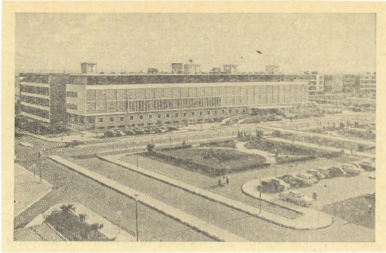
مبنى الجراحة في مستشفى الصباح
